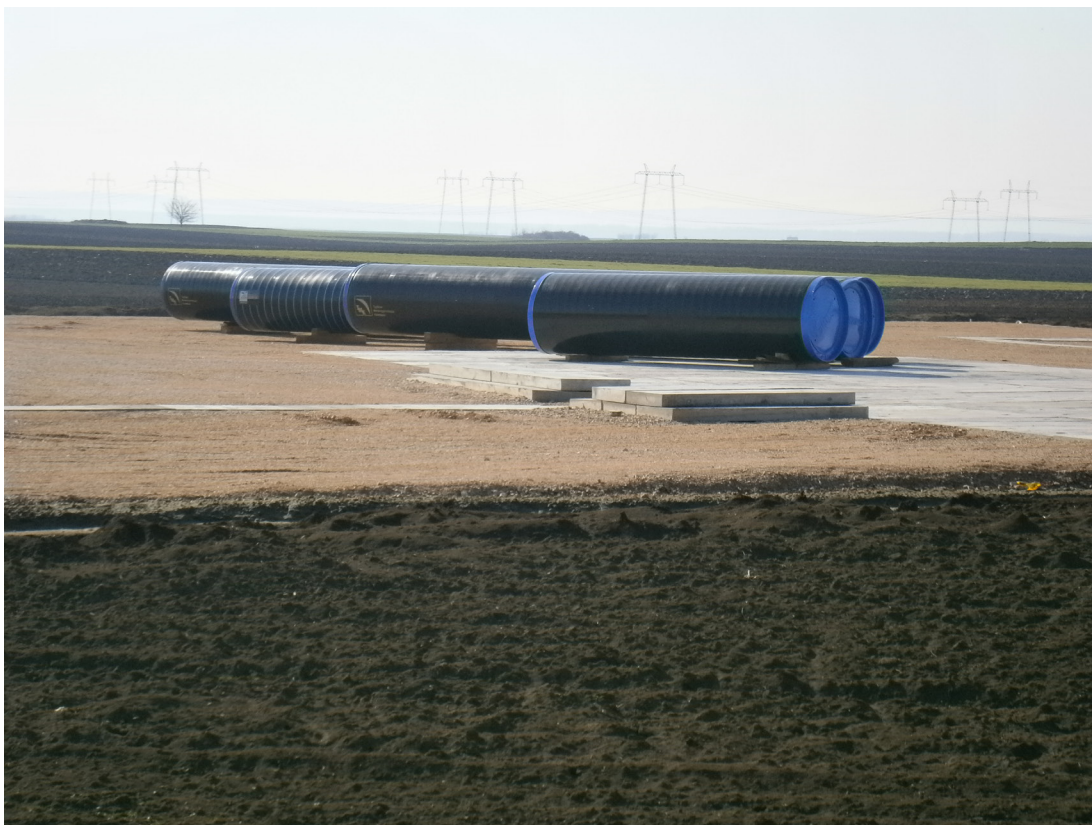
Slika 1. Prve zavarene cevi gasovoda na putu Šajkaš-Kovilj.
